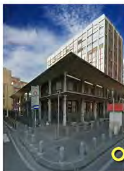
Palazzo degli Uffici Segreteria Studenti Via Giulio Cesare Cortese, 29 - Napoli
