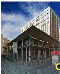
Palazzo degli Uffici Segreteria Studenti Via Giulio Cesare Cortese, 29 - Napoli
